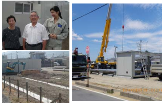
土地、工事人手確保に苦戦するも、地元内外の支援により 建設に着手できた
